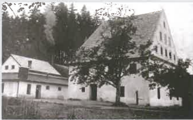
Budynki elektrowni i administracji papierni (po prawej stronie) w roku 1915. Poddasze wysokiego budynku pokrytego gontem służyło do suszenia wyprodukowanego papieru, Národní památkový ústav, kolekcja zdjęć zamku Hradec nad Moravicí
