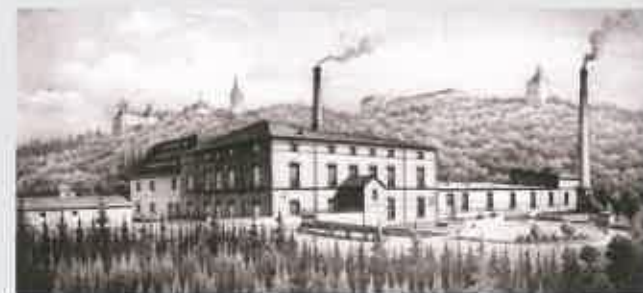
Hradecká lepenkárna (bývalá papírna) s elektrárnou, r. 1913, Státní okresní archiv Opava
